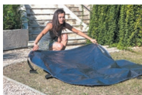
Isolation thermique au sol
